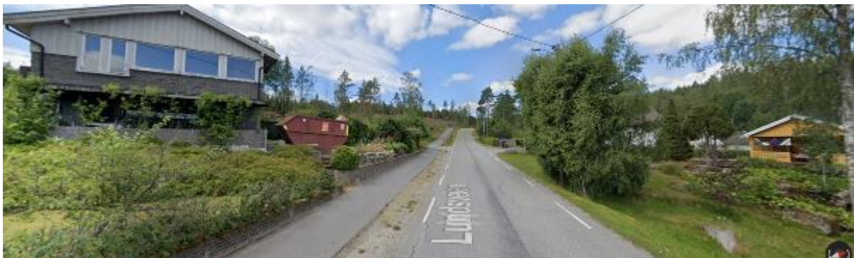
Småhusbebyggelsen langs Lundsveien planområdet og eksisterende innkjørsel bak eneboligen til venstre i bildet.
